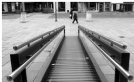
Rampa de acceso
